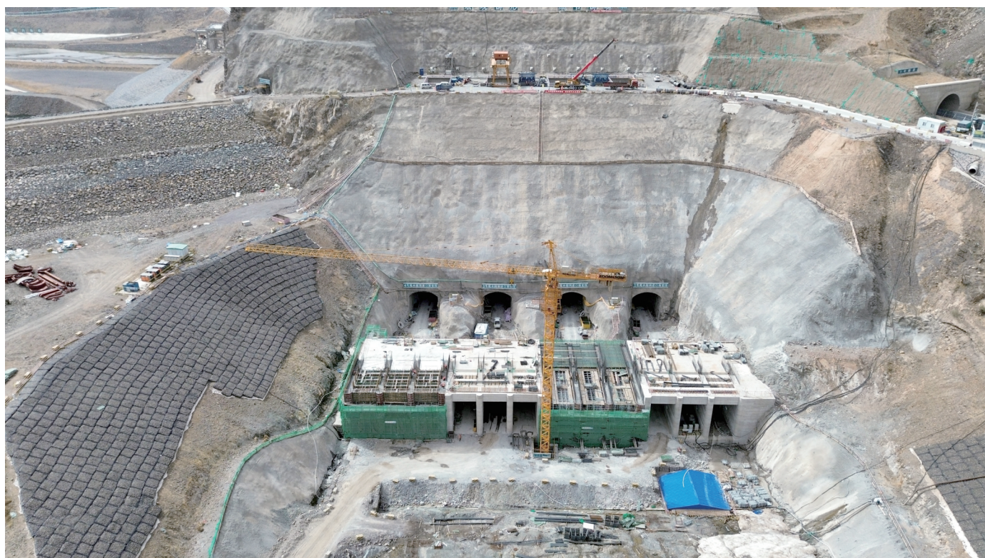
国网新源内蒙古芝瑞抽水蓄能电站地下厂房日前开挖完成,开始进入机电设备安装阶段。
