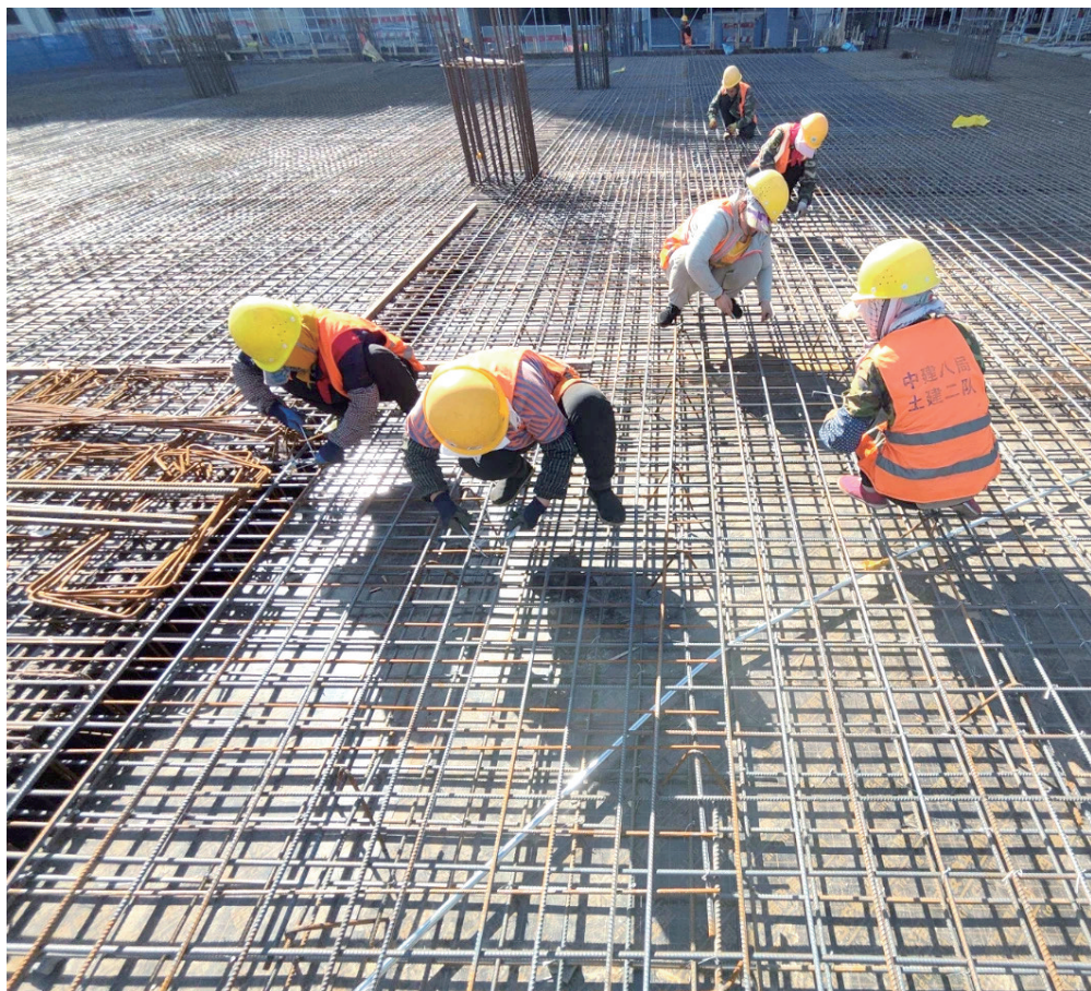
“五一”假期的赤峰市医院新城分院项目施工现场,900余名建设工人正在紧张施工作业中。
