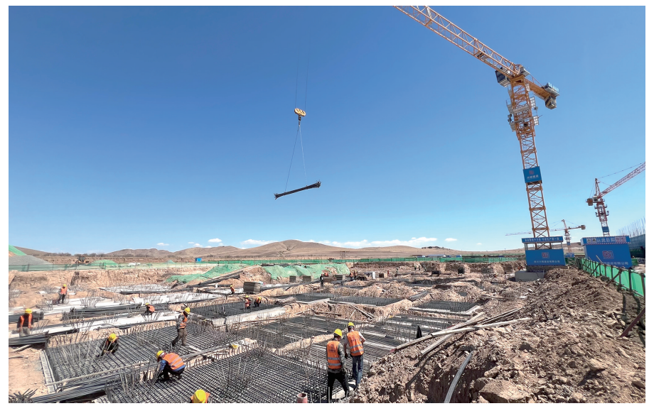
飞鹤(阿鲁科尔沁)智能化生态产业园项目建设火力全开。
