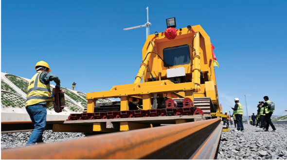
第一对500米长钢轨在乌兰察布市丰镇市集大原高铁建设现场顺利铺设。 胡俊楠 摄
