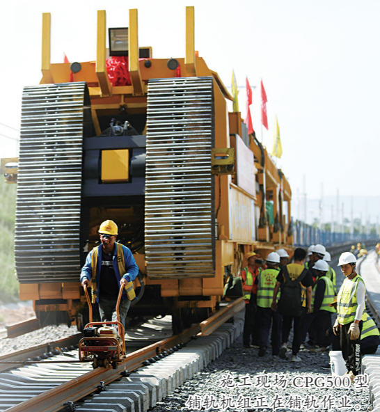
施工现场CPG500型铺轨机正在铺轨作业。 纪恩泉 摄
