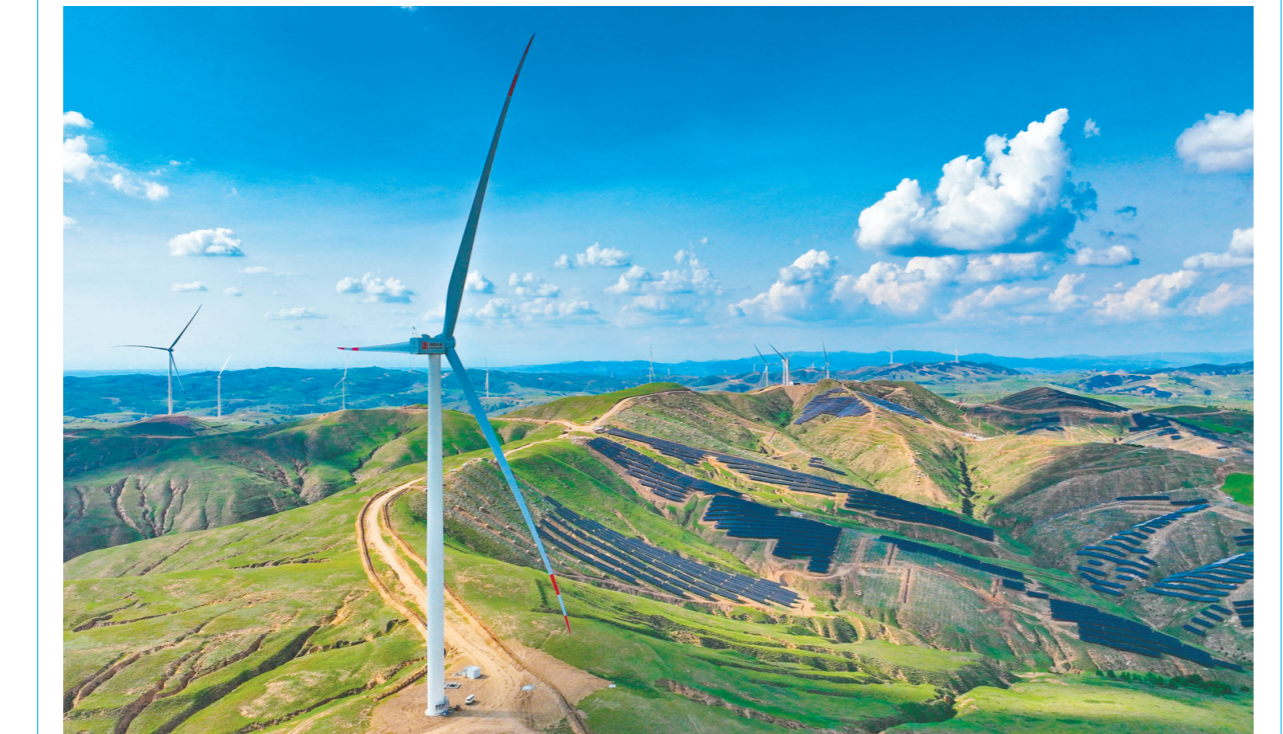
绿电进京 大唐托克托发电公司加快推进新能源外送项目建设进度,进京绿电目前已突破3亿千瓦时。图为无人机拍摄的该公司蒙西托克托200万千瓦新能源外送项目。
