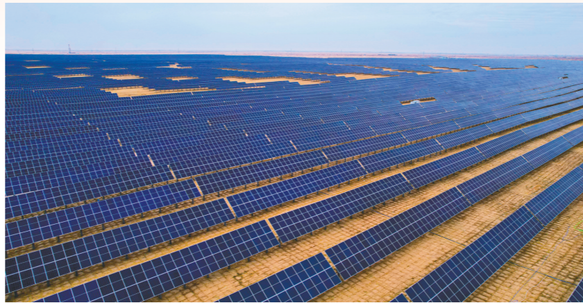
磴口县85万千瓦光伏+生态治理项目区。
