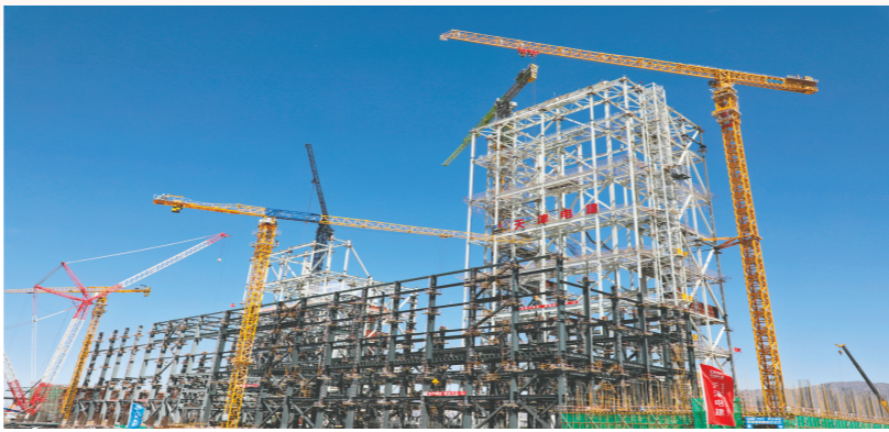
金山热电厂三期项目正在如火如荼地建设。
