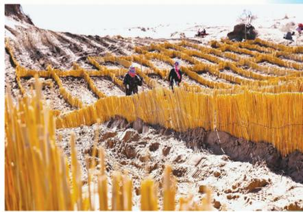
在呼伦贝尔市陈巴尔虎旗呼和诺尔镇防沙治沙项目施工现场,工人正在扎制芦苇沙障。
