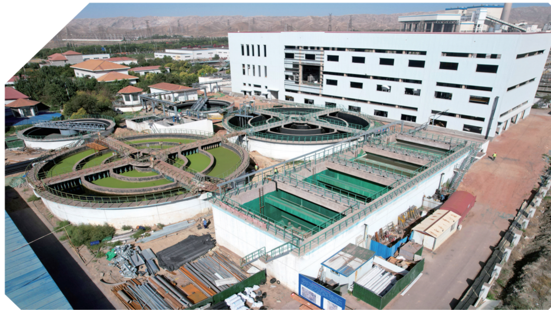
海南区再生水及资源综合利用项目建设完成。
