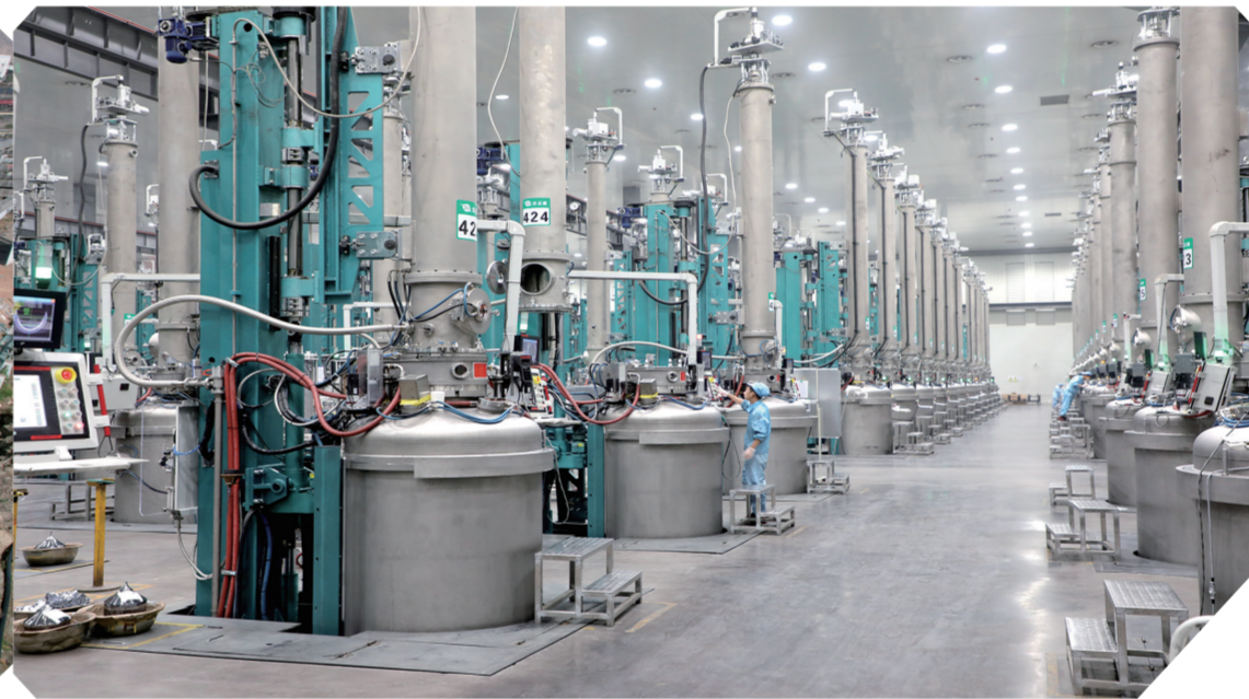
京运通光伏新材料项目。
