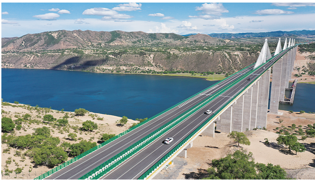
图为经乌高速重要控制性工程——西拉沐沦河特大桥,该桥是目前世界上首座在风积沙峡谷区建设的大型桥梁。
