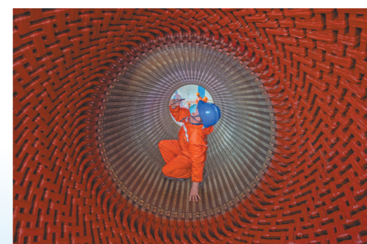
技术人员在特高压电网扎鲁特换流站开展常规电力设备检修。李广杰 摄
