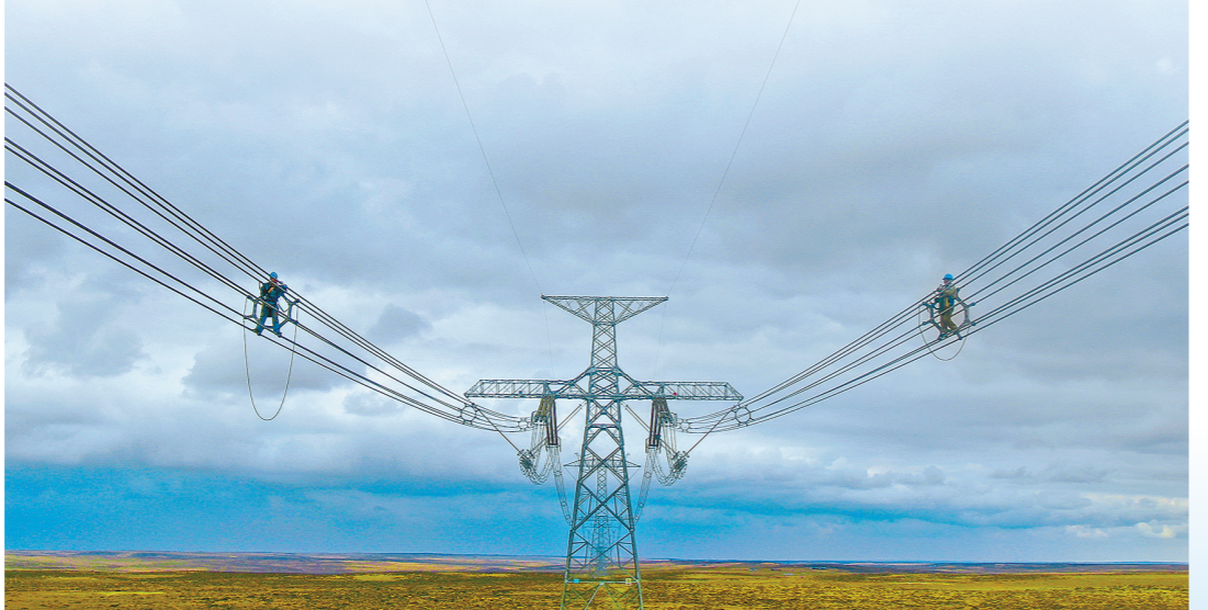
技术人员在特高压电网±800千伏昭直直流线路开展检修作业。
