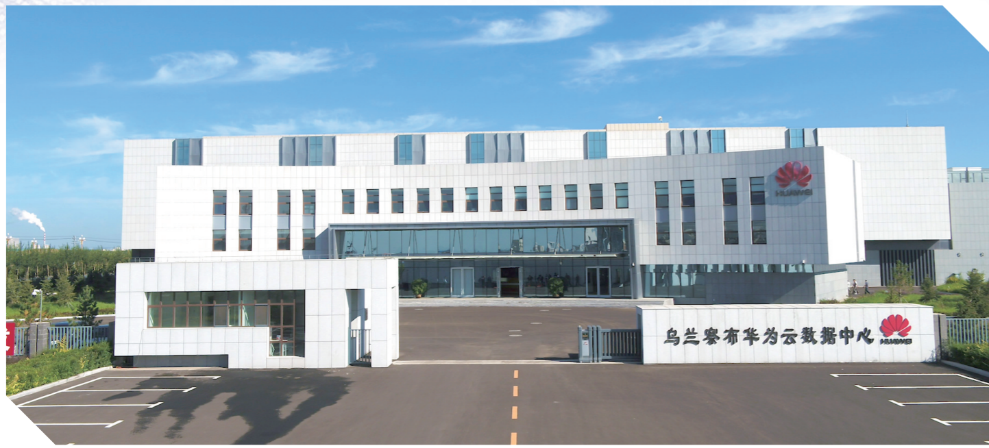
乌兰察布华为云数据中心。
