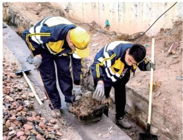
包头工务段职工对雨后排水沟淤堵杂物进行清理。靳宏伟 摄
