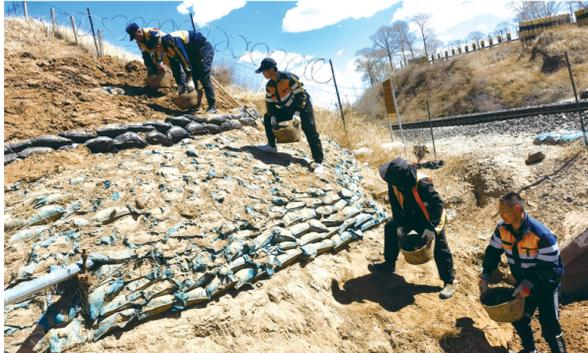
大板综合维修段职工维修石笼筑牢防洪堤坝。周金涛 摄
