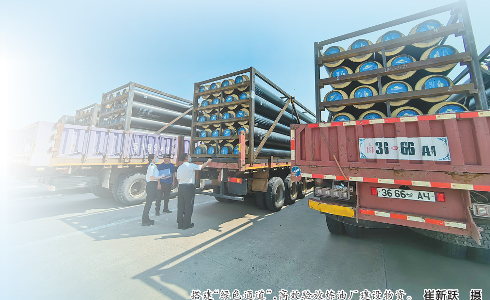
搭建“绿色通道”，高效查验炼油厂建设物资。
