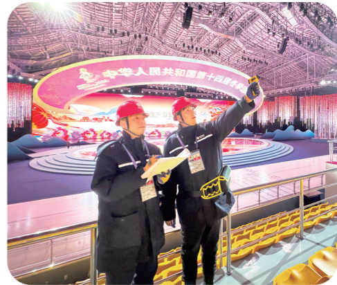
“十四冬”开幕式前一小时,国家电网蒙东电力蒙古马(呼伦贝尔)共产党员服务队队员对比赛场馆用电设备进行隐患排查,确保“十四冬”开幕式期间电力安全稳定供应。赵永生 摄
