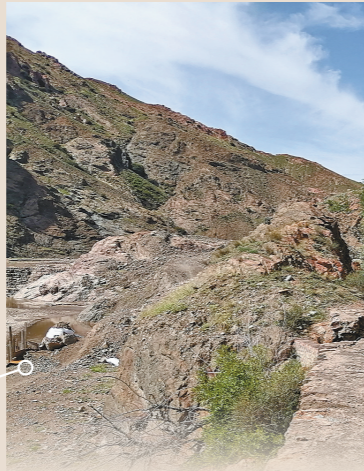
五当沟口出水坝，在原有基础上加固，沿用至今。
