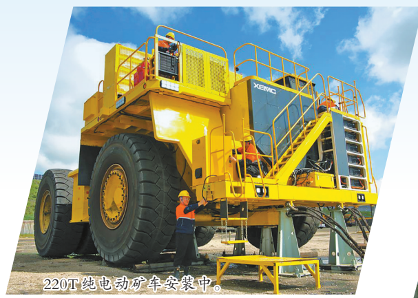
220吨纯电动矿车安装中。
