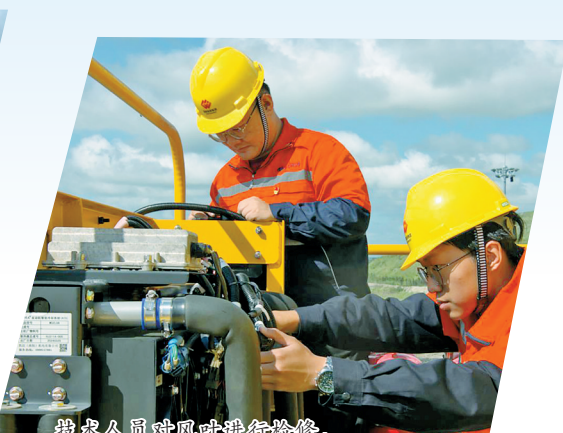
技术人员对风叶进行检修。
