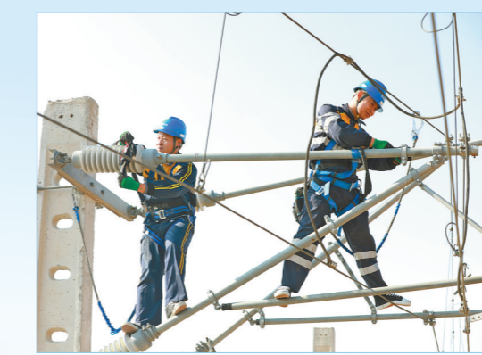
检修列车接触线和吊弦设备。张永坤 摄
