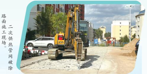
路面施工现场。二次供热管网破除。
