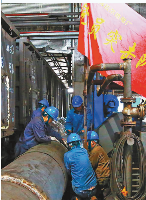
海拉尔热电厂党员突击抢修组进行抢修演练。
