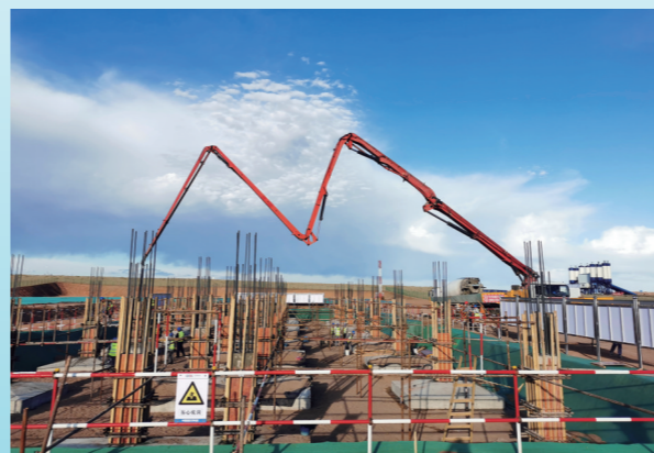
苏尼特左旗京能50万千瓦风电项目施工现场。
