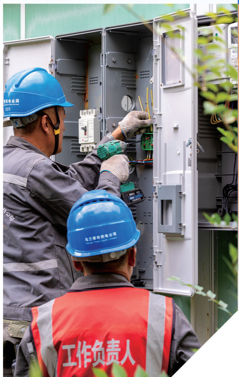
为小区的电力设备设施进行表计更换、线路铺设、设备安装、调试等工作。 赵昱 摄
