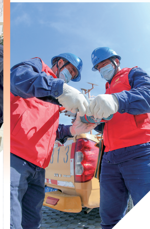
开展非电网供电治理工作。 王雍朝 摄
