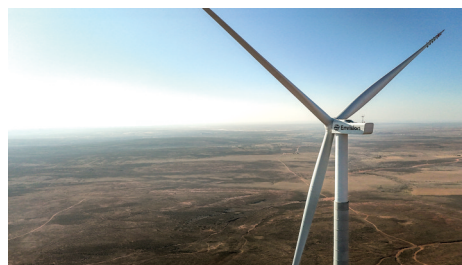
自研190米智能风机混塔在内蒙古完成吊装，刷新全球混塔最高纪录。
