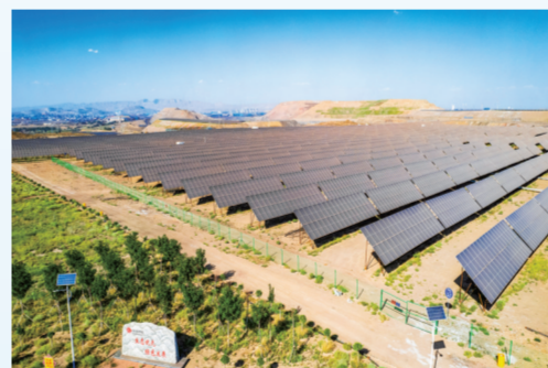
乌海能源公司100兆瓦光伏发电项目。田杰光 摄
