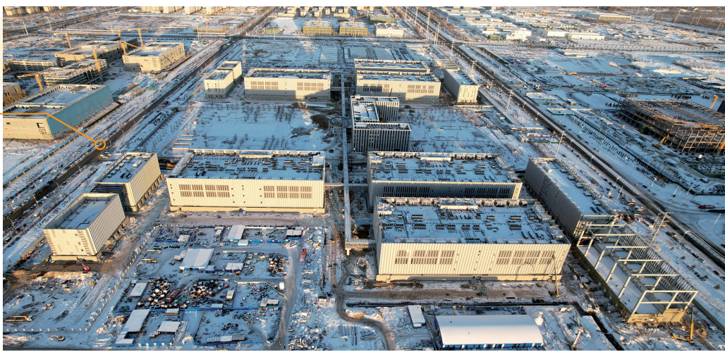
中国农业银行数据中心(呼和浩特)第三分部项目。
