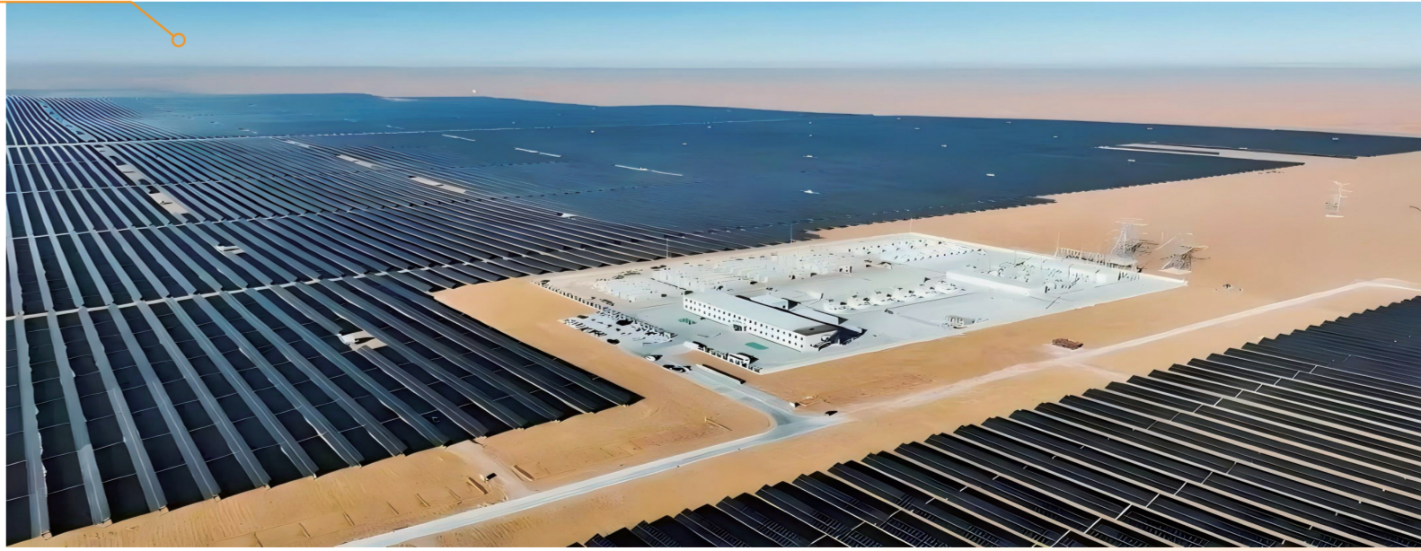
阿拉善盟内蒙古华电腾格里100万千瓦光伏发电一、二期工程建设现场。
