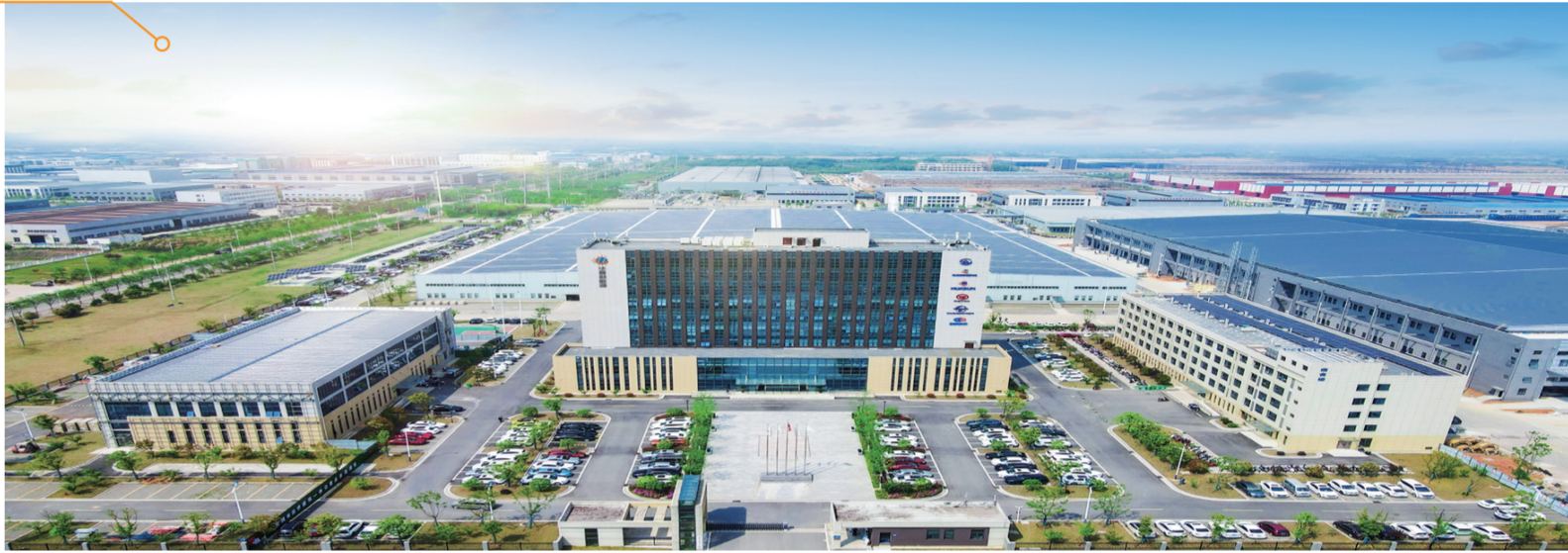
巴彦淖尔市内蒙古华晟年产3GW高效光伏组件建设项目。
