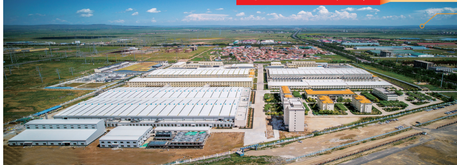
乌兰察布市东阳光洋电子材料年产2000万平方米积层箔生产线项目。
