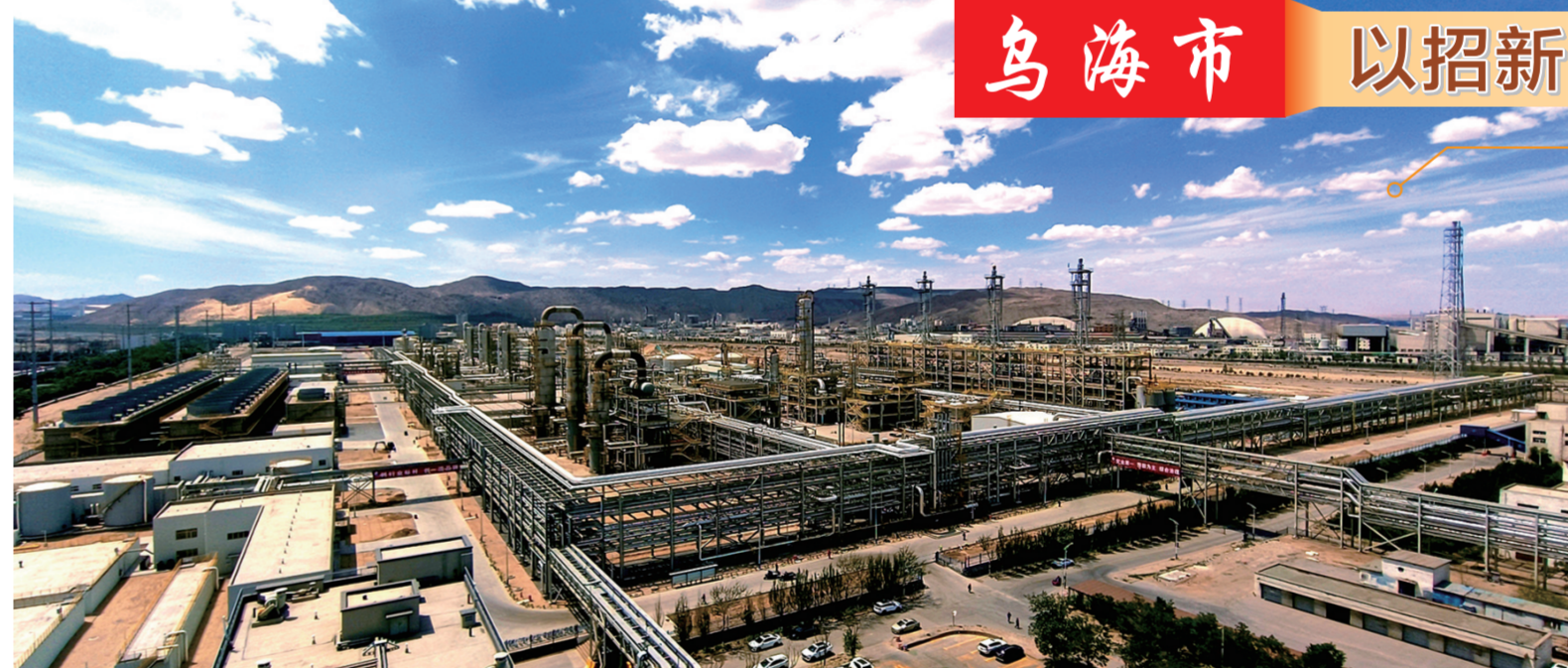
乌海市内蒙古君正化工一期可降解材料项目。
