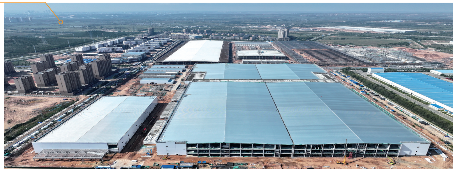
鄂尔多斯市晶澳太阳能全产业链低碳示范基地项目。
