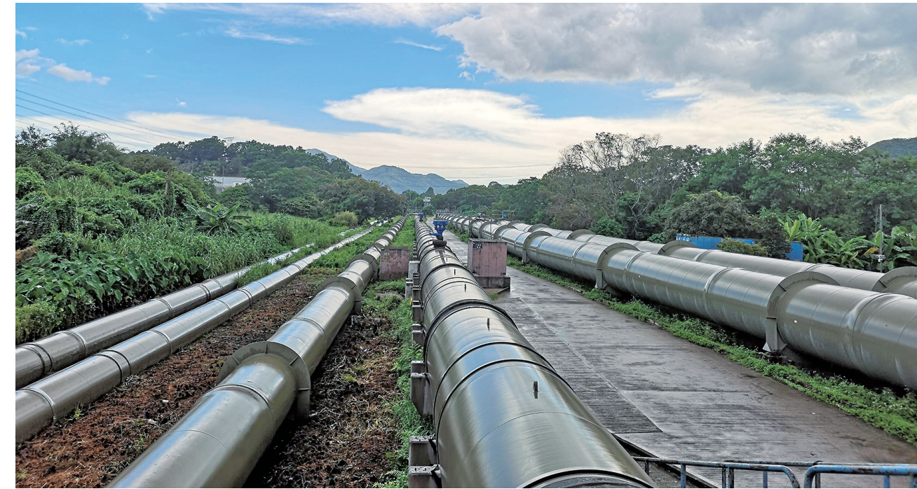
这是木湖原水抽水站的巨型输水管(资料照片)。东江水抵港第一站是位于香港上水的木湖原水抽水站,它是香港配合东江供水工程而兴建的重要设施。
