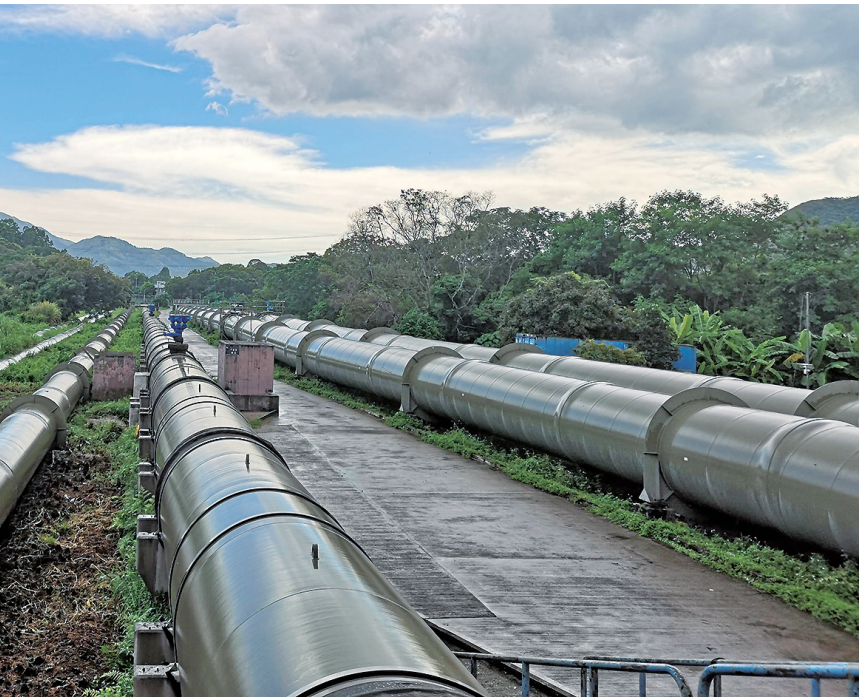
这是木湖原水抽水站的巨型输水管(资料照片)。东江水抵港第一站是位于香港上水的木湖原水抽水站,它是香港配合东江供水工程而兴建的重要设施。
