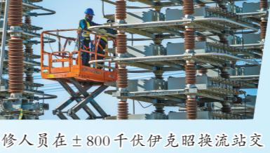
检修人员在±800千伏伊克昭换流站交流滤波器场开展电容器接头螺栓紧固工作。
