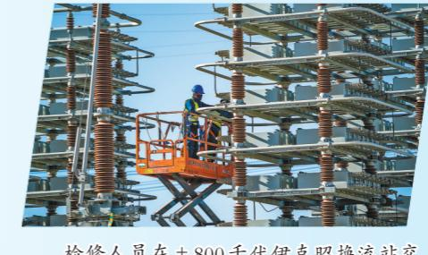
检修人员在±800千伏伊克昭换流站交流滤波器场开展电容器接头螺栓紧固工作。
