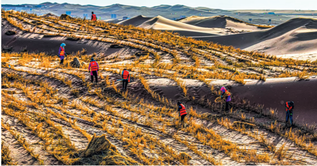
腾格里沙漠边缘的通古淖尔苏木，工人正在扎草方格。
