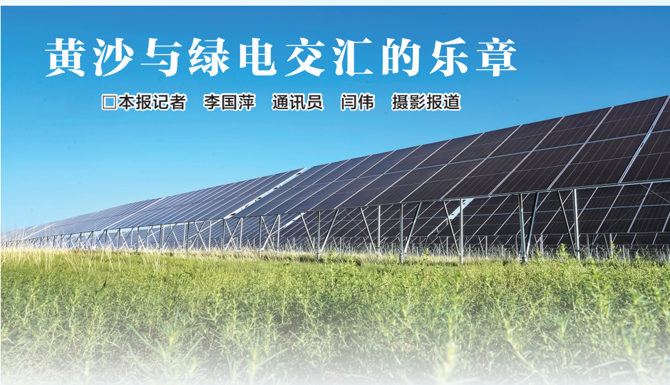
采用螺旋桩工艺避免破坏草场。
