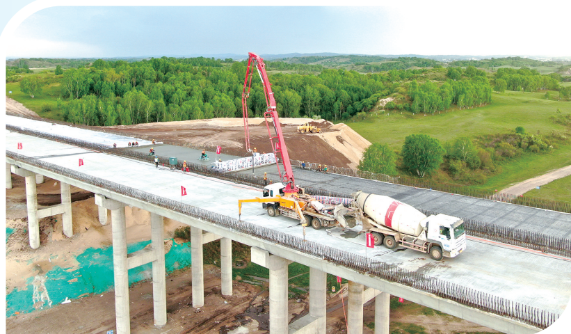
利用桥面激光摊铺技术进行桥面施工作业。
