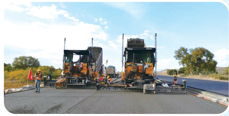
3D智能摊铺助力公路水稳基层施工实现毫米级精度。
