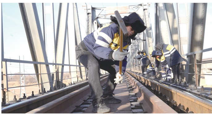
马瑞祥带领职工在三盛公黄河铁路1号特大桥上检修线路设备。汤鸿鸣 摄
