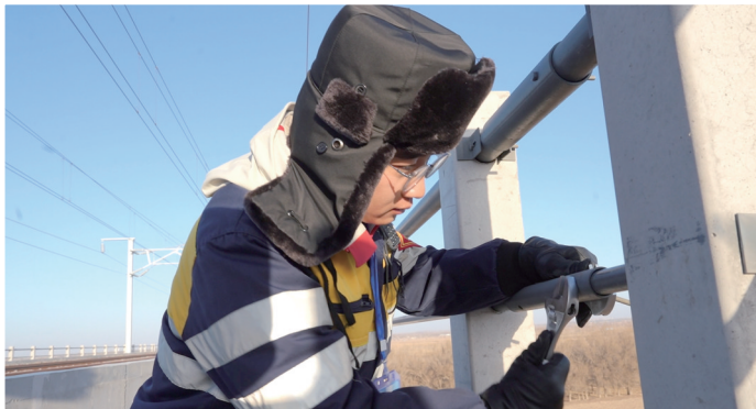
白宇泰正在复紧磴口黄河特大桥栏杆螺栓。董杰 摄
