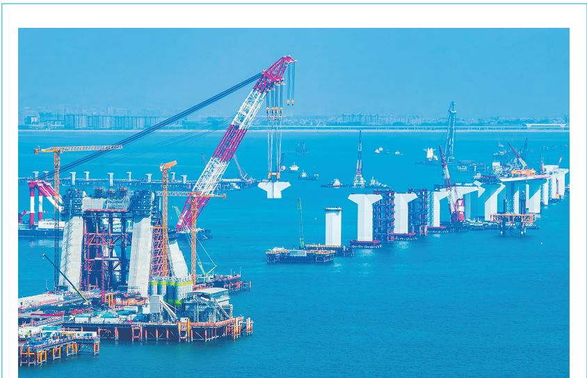
厦金大桥(厦门段)项目各项施工进展顺利 厦金大桥(厦门段)项目A1标段在进行沿线预制墩台吊装(2026年1月9日摄,无人机照片)。目前,厦金大桥(厦门段)项目跨海工程已从“立塔成型”转入“悬索成桥”关键施工阶段。厦金大桥(厦门段)项目于2023年10月动工,路线全长约19.6公里,其中主线长约17.34公里,翔安支线总长约2.27公里。 新华社记者 魏培全 摄
