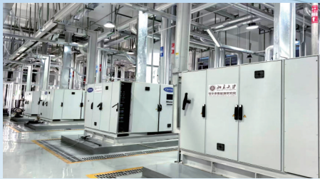
全球首套宽温域大型化多源跨临界CO 2 冷热一体化装备系统。
