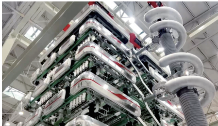
特高压混合换相换流阀。
