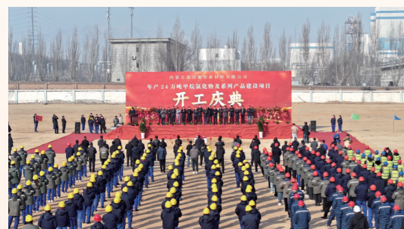
聚智新材料项目开工,政企携手共筑产业新动能。
