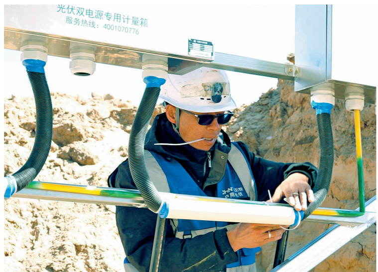
施工人员正在安装光伏设备。
