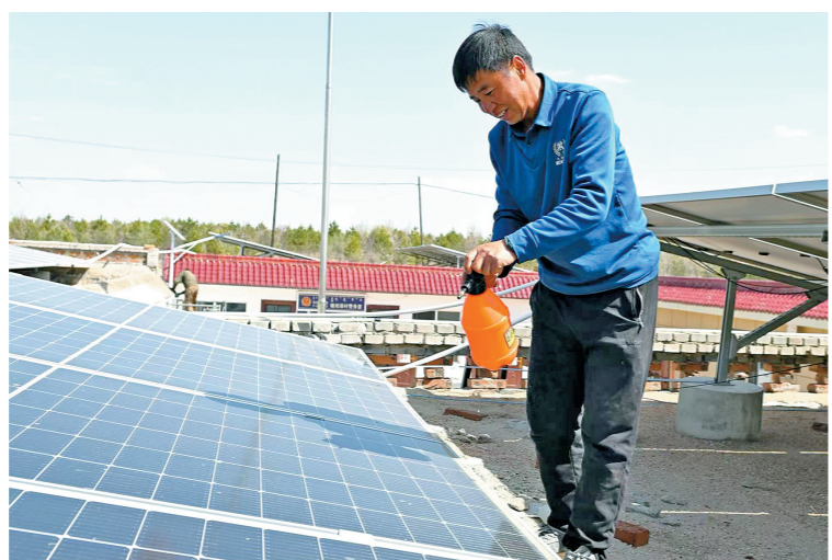
村民清洗维护光伏板。
