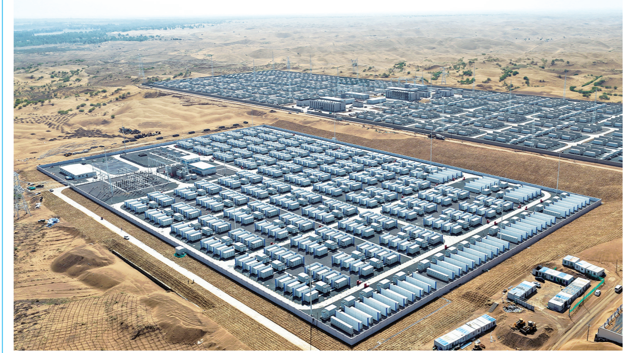
储能项目建设稳步推进
