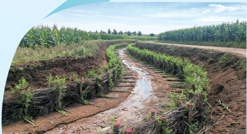
东北黑土区兴安盟扎赉特旗侵蚀沟治理项目柳桩护岸工程。
