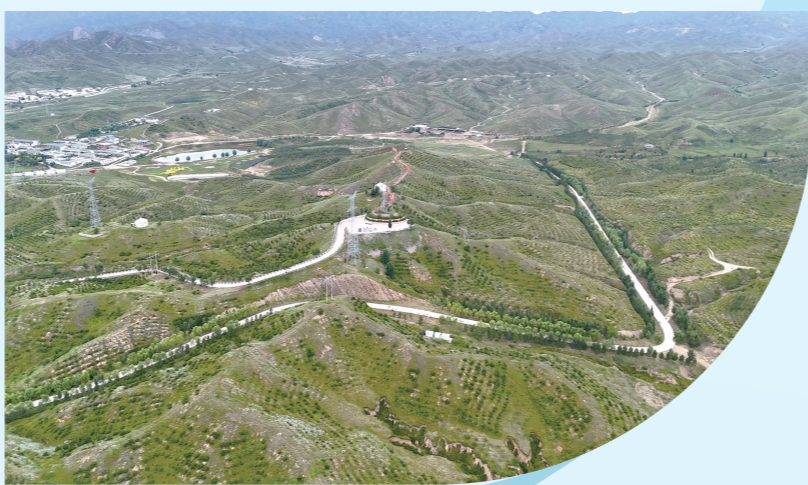
包头市青山区本坝沟生态清洁小流域项目。
