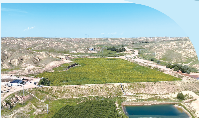
黄土高原鄂尔多斯市杭锦旗国家沟骨干坝治理工程。
