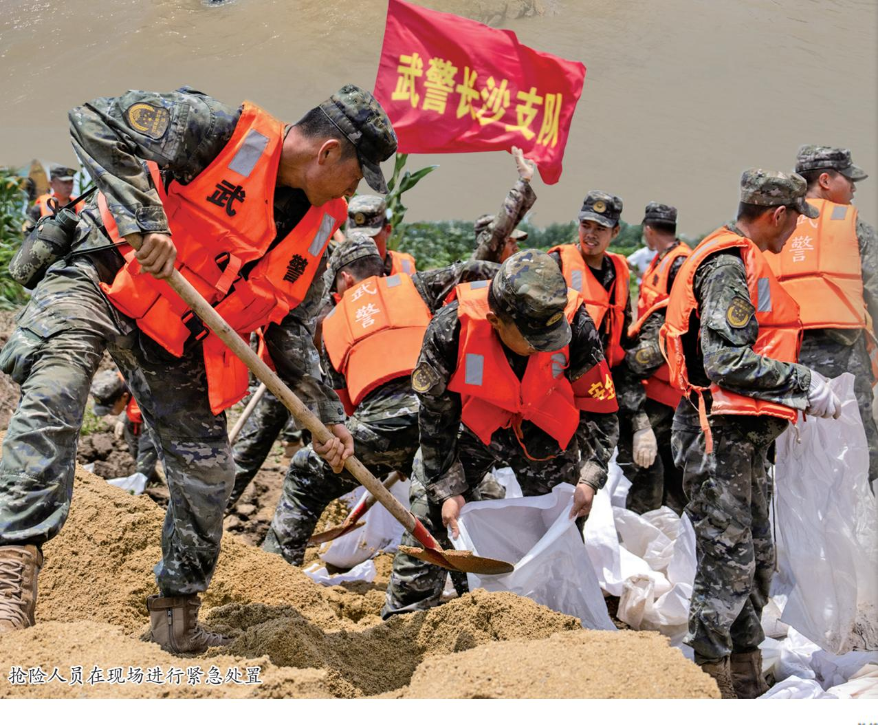
7月8日6时，晨光初露，湖南华容团洲垸洞庭湖大堤决口封堵处一片忙碌，尘土飞扬。此时，决口已从最初的226米缩短至97米。
