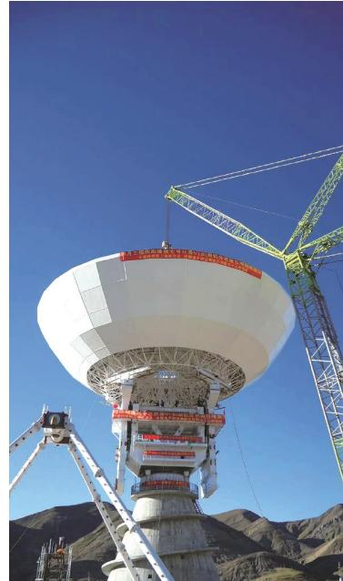
工程人员、基建工程队和上海天文台工作人员入驻日喀则4100米海拔高原现场,通过6个月艰苦努力,7日上午顺利完成主反射体吊装。
