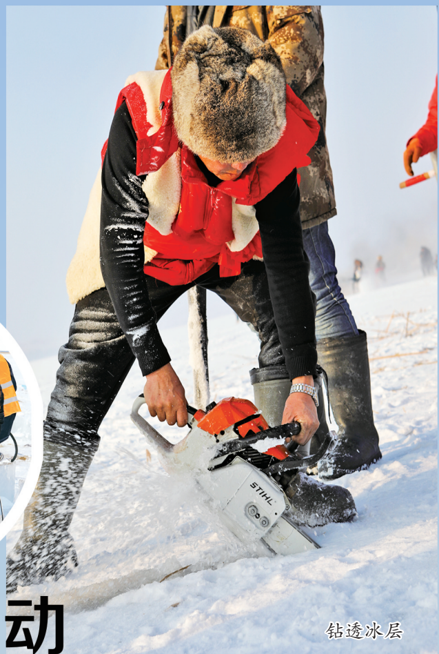
园区建设进行中
