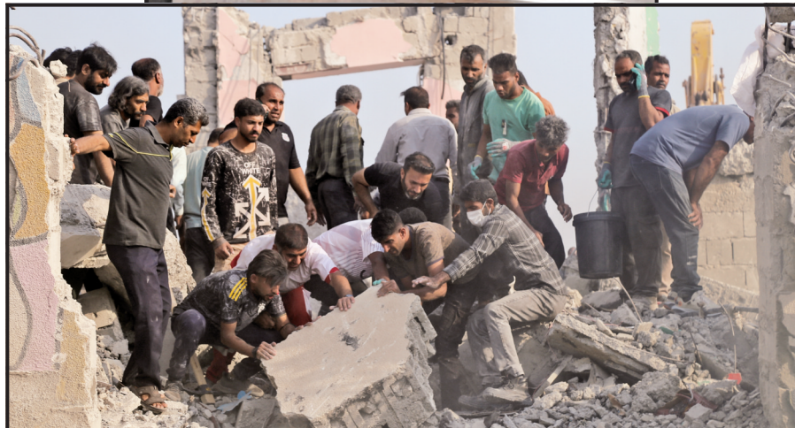
2月28日,在伊朗米纳卜市一所被袭击的小学,救援人员和当地居民试图从废墟里营救伤员。
