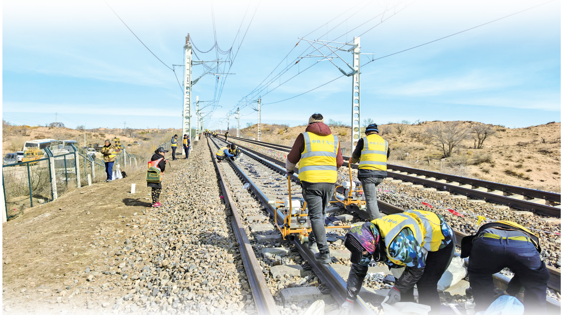
太锡铁路桑根达来北站至锡林浩特站下行线换轨施工正式启动
