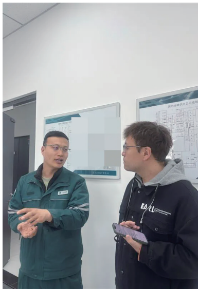
站长高燕博向记者介绍变电站智能监控系统
