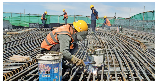
S28乌(丹)天(山)高速天山西互通匝道桥施工现场
