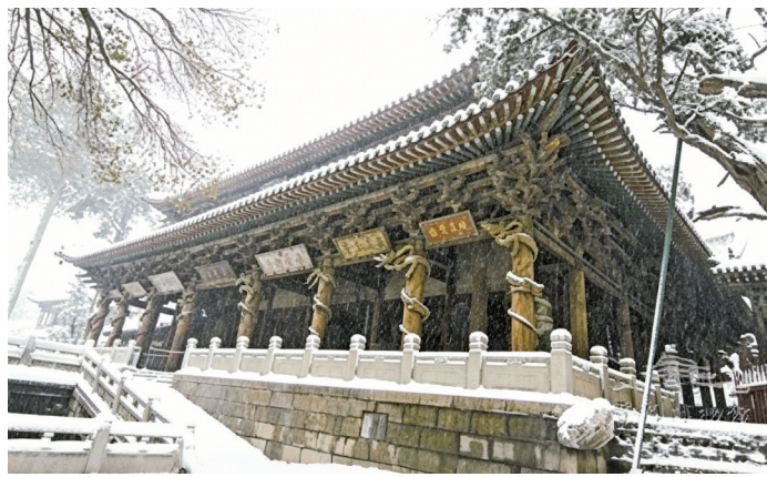
山西晋祠圣母殿为中国现存最完整的宋代木构建筑代表作之一，有显著的侧脚和生起。
