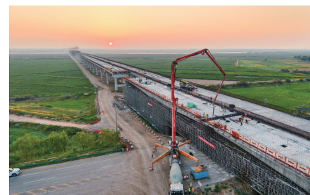
施工现场(内蒙古自治区交通运输厅供图)
