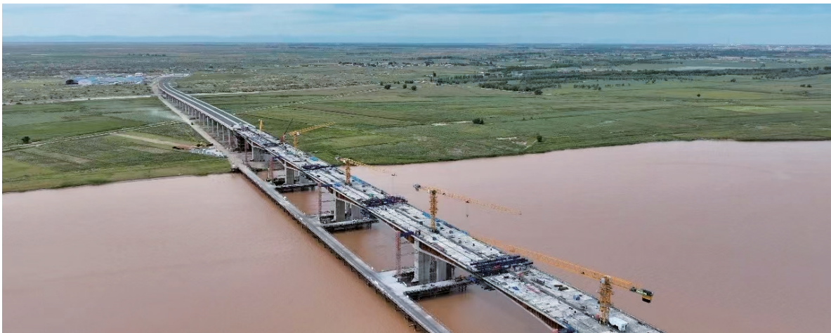
施工现场(内蒙古自治区交通运输厅供图)
