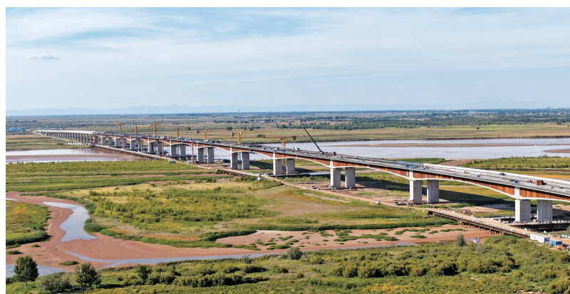
施工现场(内蒙古自治区交通运输厅供图)
