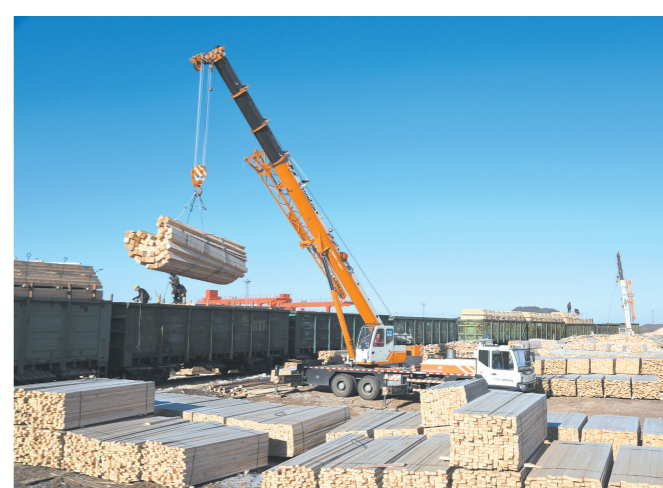
二连站正在进行进口木材卸车作业。 纪恩泉 摄
