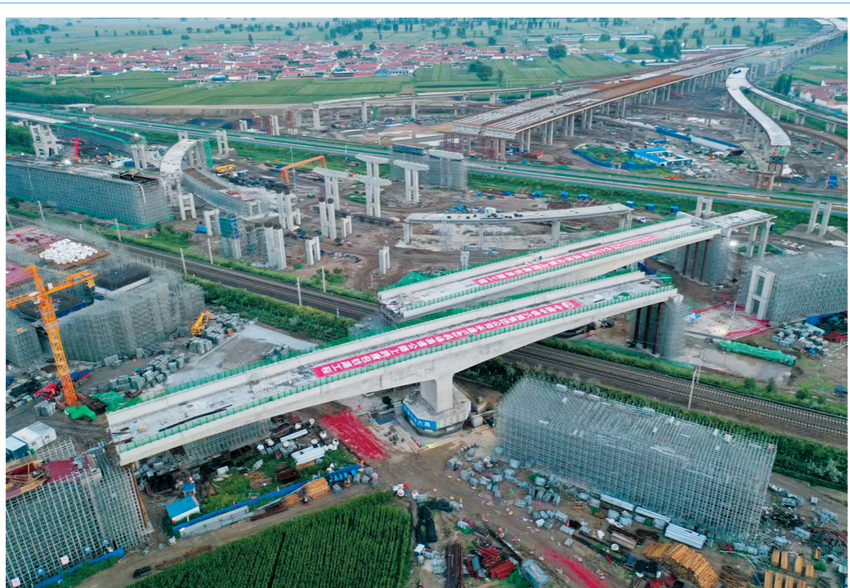
S43呼和浩特机场高速跨铁路转体桥成功转体
