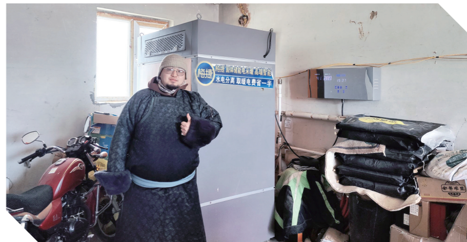
二连浩特牧民家里安上了梅捷固体储热供暖设备。
