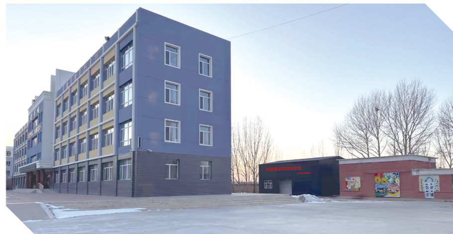
赤峰市桥头中学梅捷固体储热清洁供暖改造项目。
